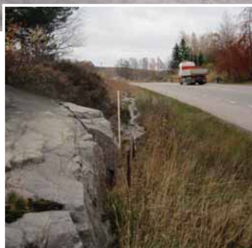
Bild 17. Den nya cykelbanan kommer att gå precis intill hällen med ristningen.
